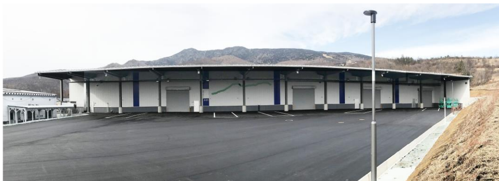
新倉庫全景 (新しいロゴマークを配しています)
